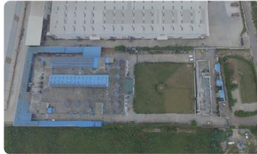
100kW PLANT, PILAKHUA
